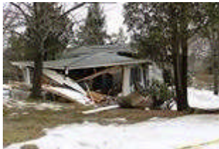
Wegen Bohr-Aktivitäten Methan-Gas erzeugte Haus-Explosion
